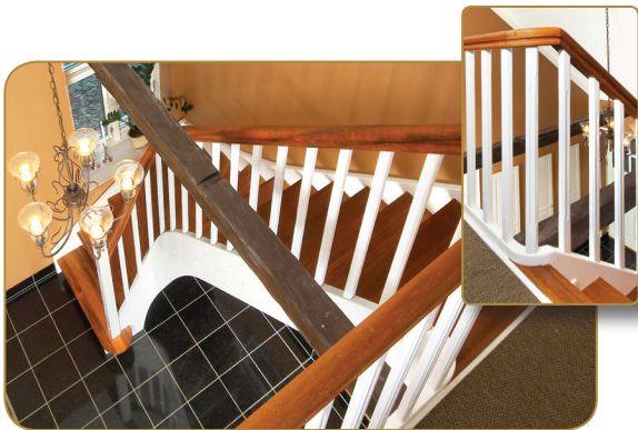
Krumning i overgang til vandret gelænder.
